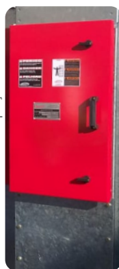
Janela de Inspeção
